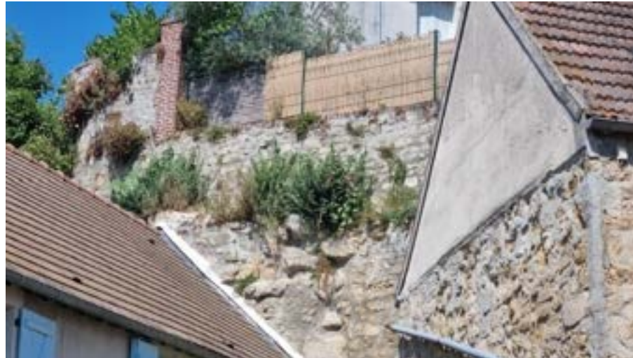
Chemin de ronde en haut du lavoir.
