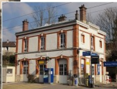
Bâtiment-voyageurs de la gare.
